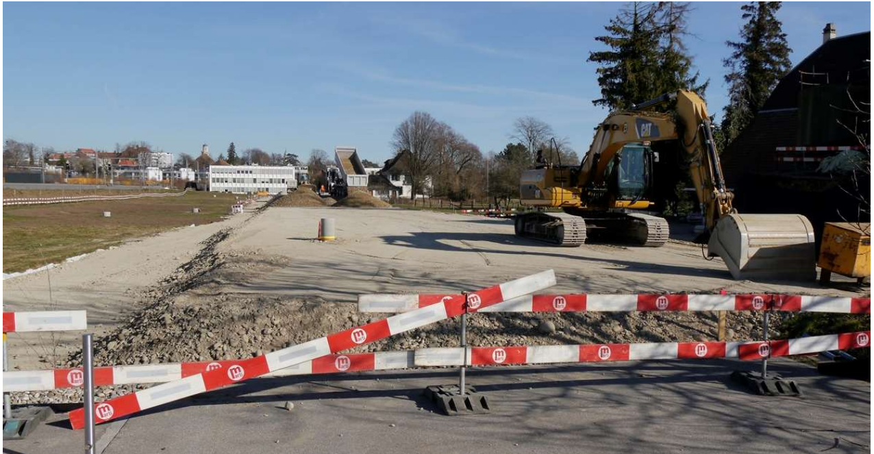
Blick von Westen auf die Vorbelastung der Erschliessungsstrasse zwischen den Baufeldern 1 (links) und 2/3 (rechts)
